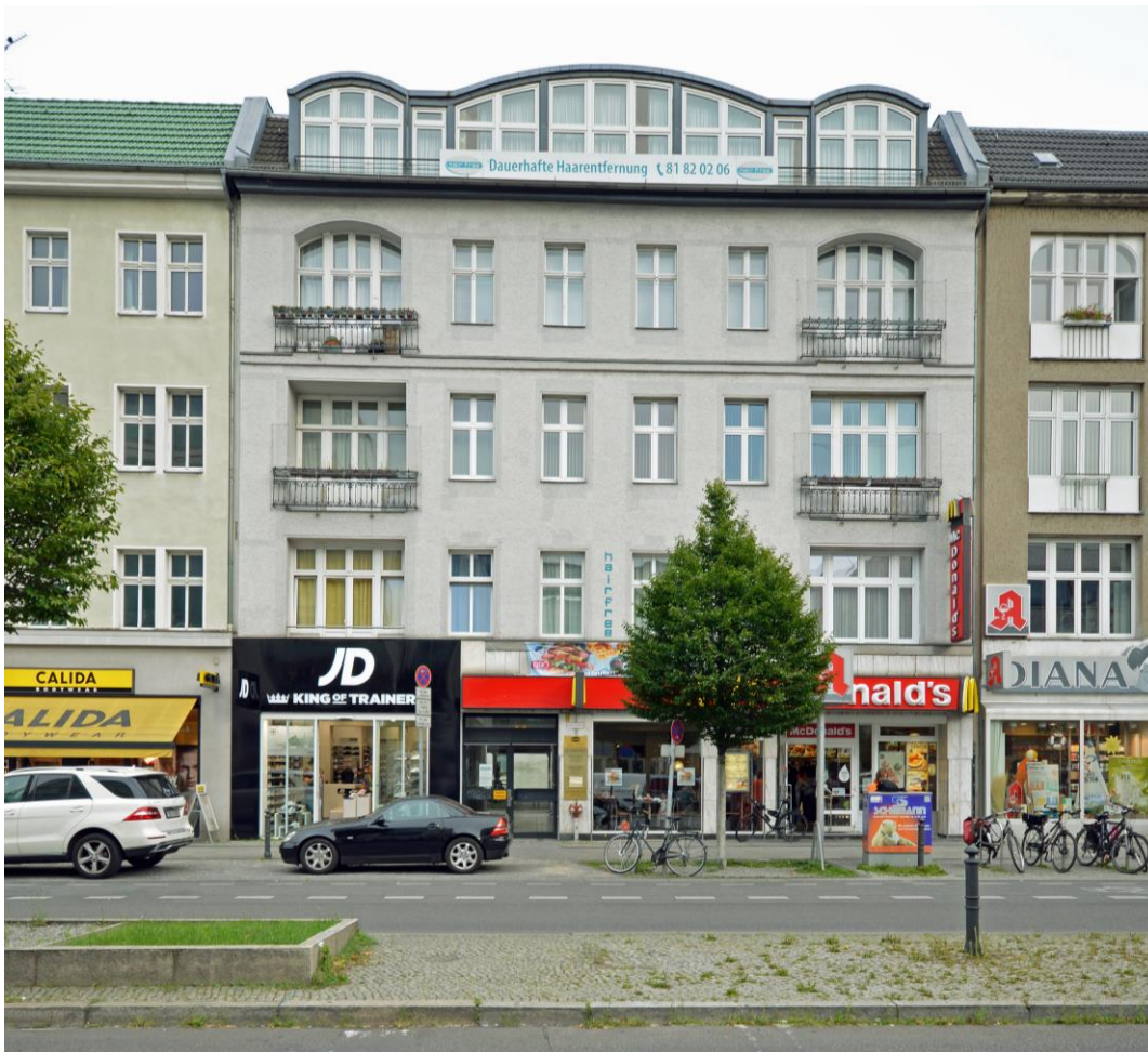
Ansicht des Ladenlokals an der Schlossstraße 117 in Berlin Foto: COMFORT
